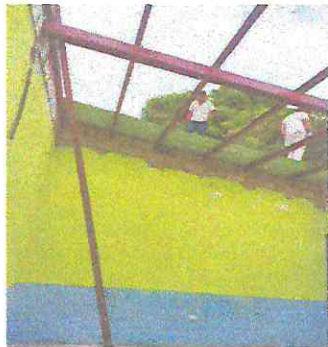
foto 3 Montaje de estructura
