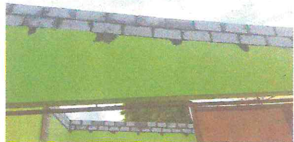
foto 6 Levantamiento de muro
