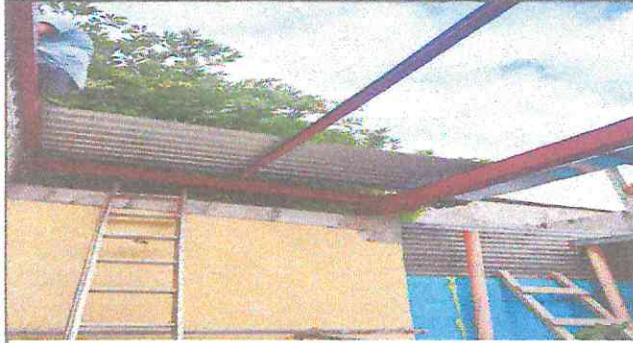
foto 1 desmontaje de canales
