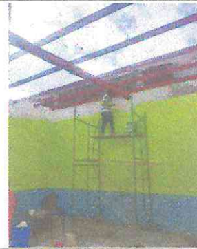
foto 2 desmontaje de lamina existente
